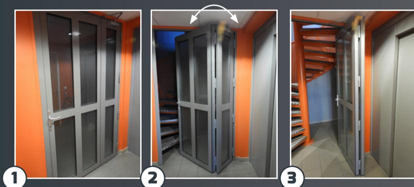
Porte repliable pour un gain de passage
